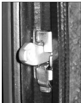
Foto af kolve korrekt placeret i kolvestyret.
